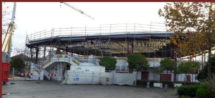
Quand toute la couverture sera remplacée, soit courant janvier, pourra commencer le décapage et la peinture des poteaux extérieurs, puis la pose du bardage vertical et enfin les peintures de toutes les parties maçonnées, intérieures et extérieures, et des boiseries.
